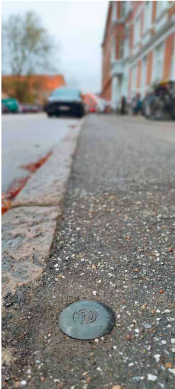
Figur 4: Sensor installeret i fortovet ved kantstensparkering i Aarhus Kommune.
