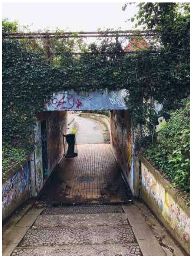
Før-billede af viadukt under banen fra Laurids Skaus Gade.
