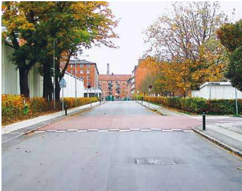
Figur 1: Eksempel på hævet krydsflade på Emil Chr. Hansens Vej på Frederiksberg. Den hævede flade er med rød belægning, som skal medvirke til at øge opmærksomheden på krydsområdet. Foto: Via Trafik.
