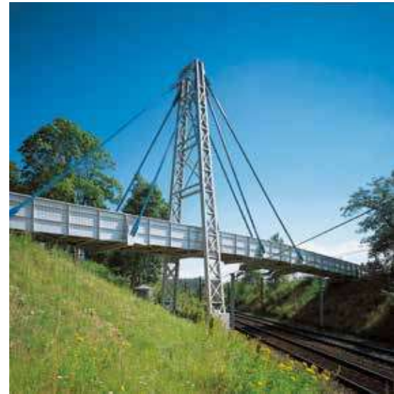
Figur 4: Stibro i Kolding (foto Fiberline) fremstillet af pultruderede profiler (1997), længde 40 meter
