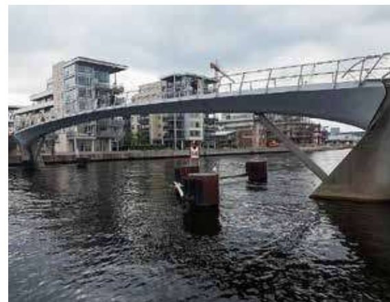
Figur 6: Sti-klapbro i CFRP i Fredrikstad, Norge, udført ved formstøbning med et spænd på 60 meter (foto: Ole Dag Johansen)
