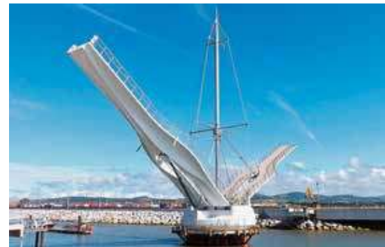
Figur 5: Klapbro Pont Draig i Wales fremstillet ved formstøbning (2013), spænd 2 x 35 meter
