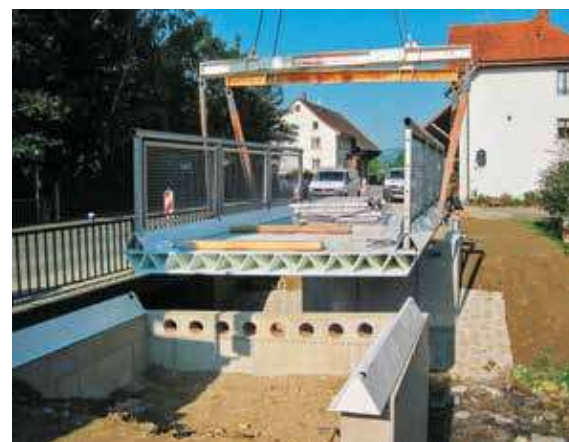
Figur 7: Vejbro udført med sammenlignede pultruderede boxprofiler. Klettgau i Tyskland, længde 7,2 meter (2017, foto Fiberline)
