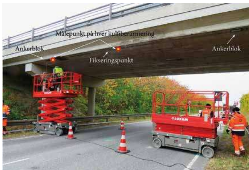
Figur 7: Montage af det nye innovative kulfiberarmersystem
