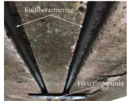
Figur 6: Fikseringspladen der sikrer fikseringspunktet midt på broen
