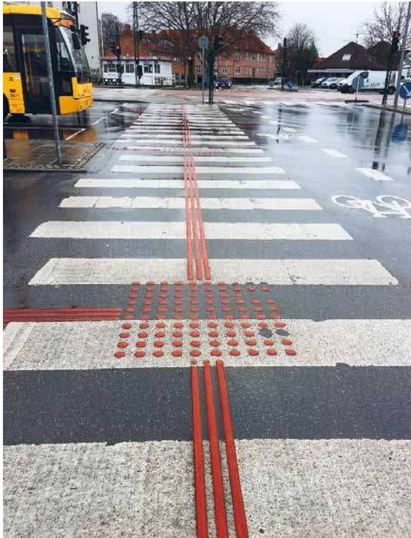
Ledelinje i fodgængerfelt over busholdepladser ved Nykøbing F. Banegård
