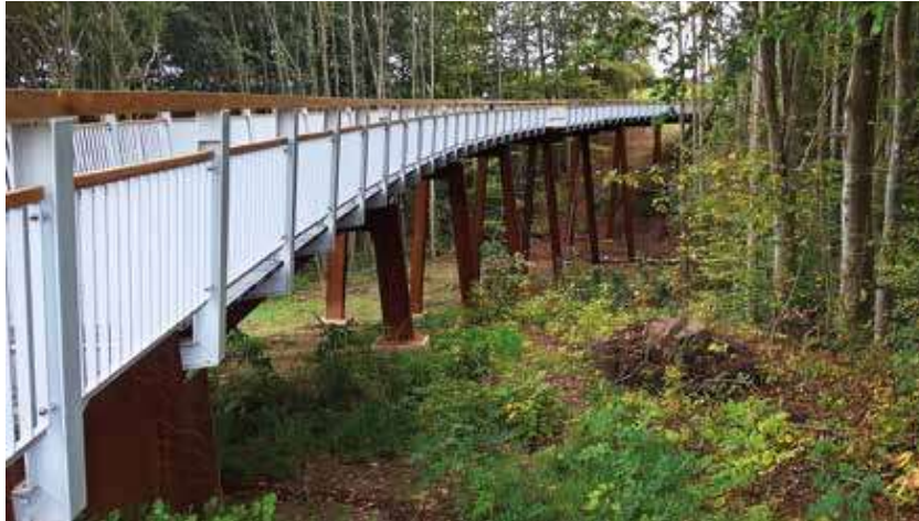
Figur 3: Broen begynder at tage form. Bemærk den stejle skråning i baggrunden.
