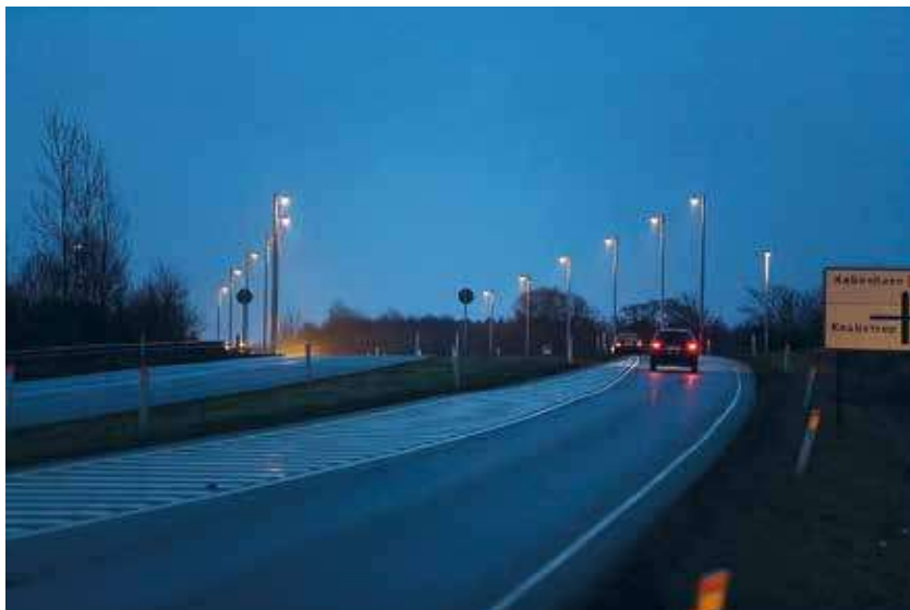
Hvad gemmer sig bag næste sving? Her er det tydeligt, at der nok kommer et kryds, og at trafikanter fra sidevejen har dårligt udsyn. Så let lidt på speederen. Vejbelystningen kan med hjælp af beregningsmetoder og software fra standarden DS/EN 13201-2 bruges til at anskueliggøre vejens forløb. (Foto fra Håndbog Vejbelystning)
