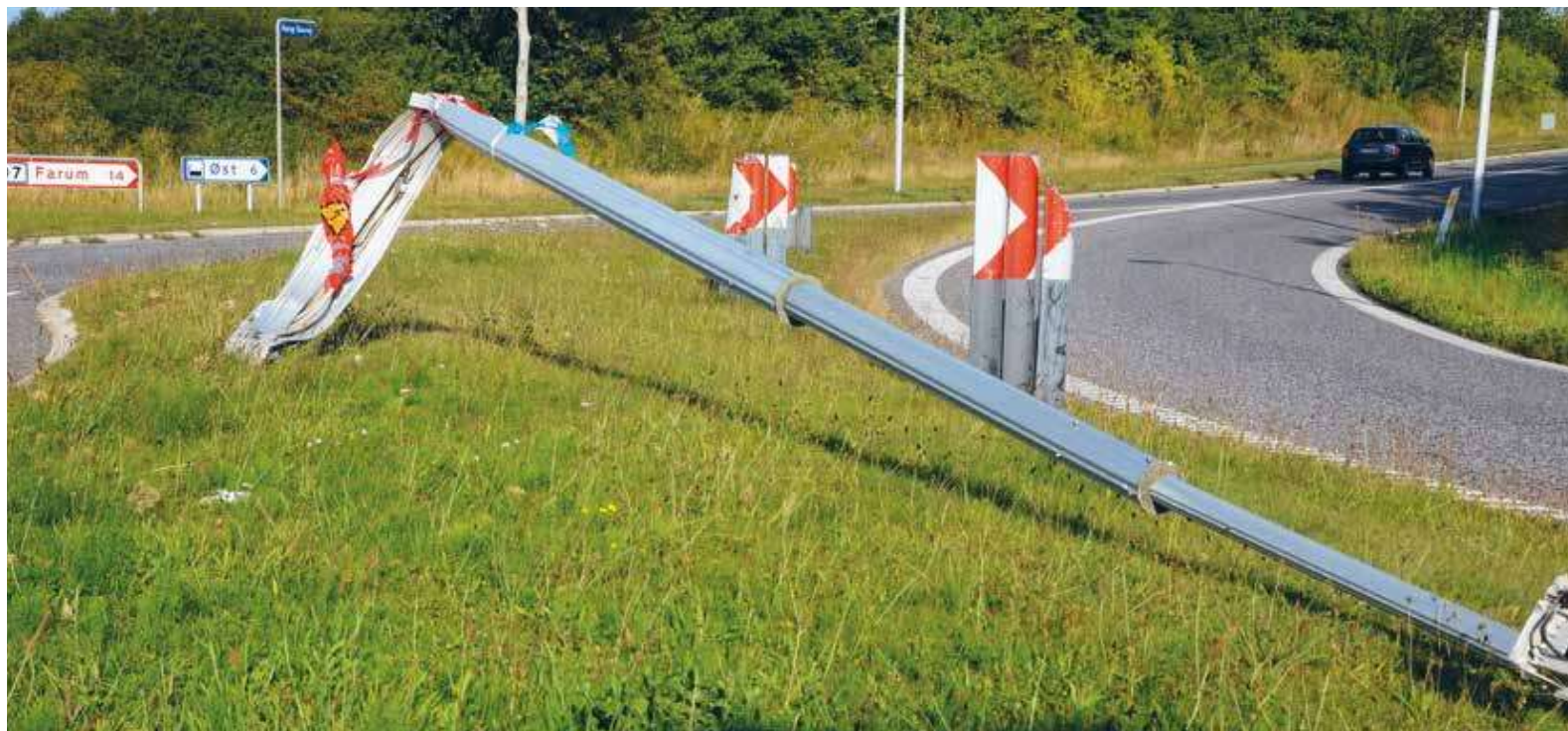
Figur 1: Billedet viser en Moramast type 100-HE-C mast, som har fanget en bil på en betryggende måde. Cirka 10 meter længere fremme er en modkørende vejbane, der ville have udgjort en stor fare for både bilens passagerer og eventuelle modkørende. Billedet er fra rundkørslen i Slangerup syd. Foto: DANintra.
