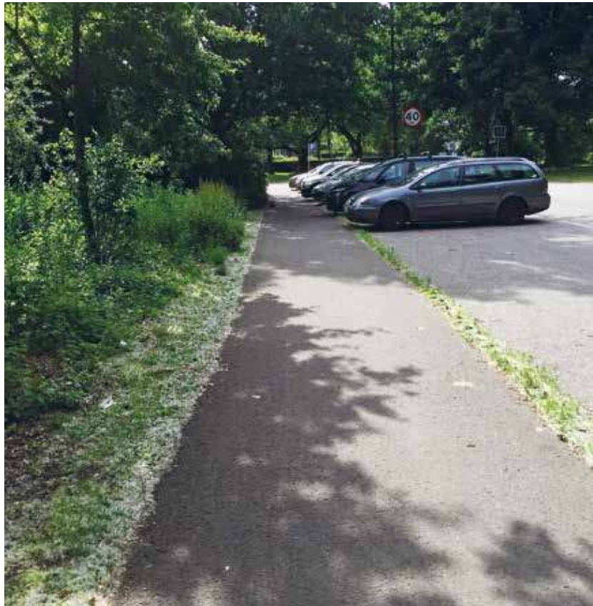
Figur 2: Stibelægning langs Pilesvinget i Brønshøj.
