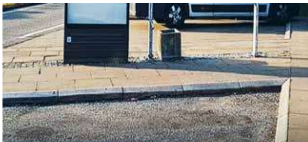
Figur 2: Eksempel på betonkantstene ved rastepladser.
