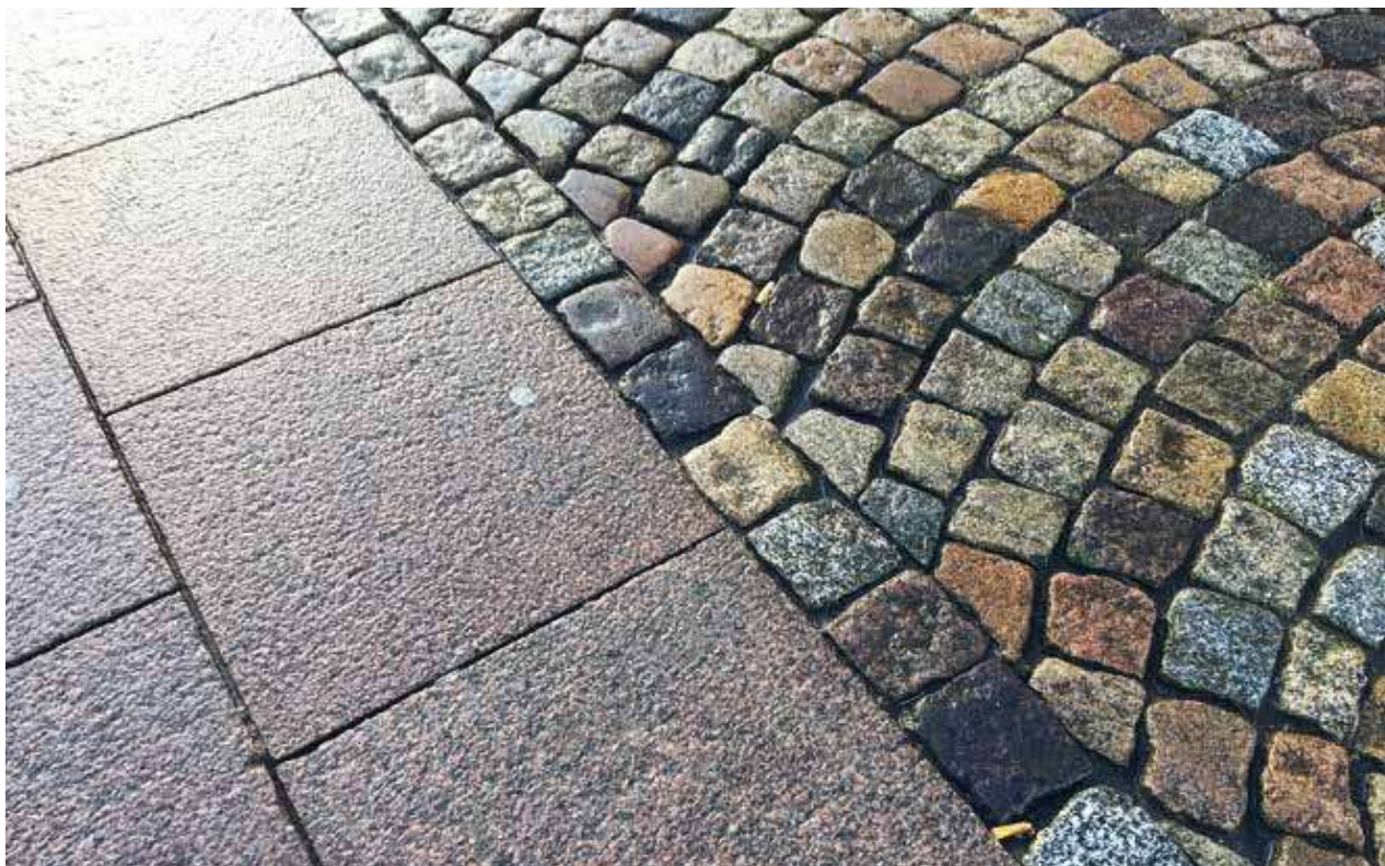
Figur 3: Jævn gangbane af granitfiser og tydelig taktile kant. Denne løsning udgør en udmærket såkaldt naturlig ledelinje.
