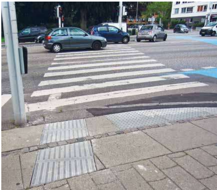
Figur 3: Færdigt anlæg med retningsfelt og opmærksomhedsfelt. Kantstenen er tilrettet til korrekt opspring. Ribbefliser er lagt i retning med fodgængerfelt, hvilket kræver tilskæringer i eksisterende belægning. Foto: Via Trafik.
