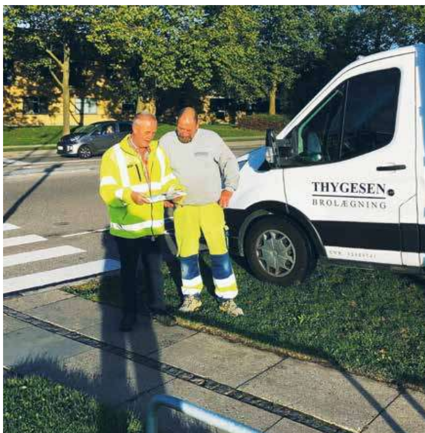
Figur 2: Glostrup Kommunes brolæggere kigger håndskitsen igennem inden anlæg. Foto: Glostrup Kommune.
