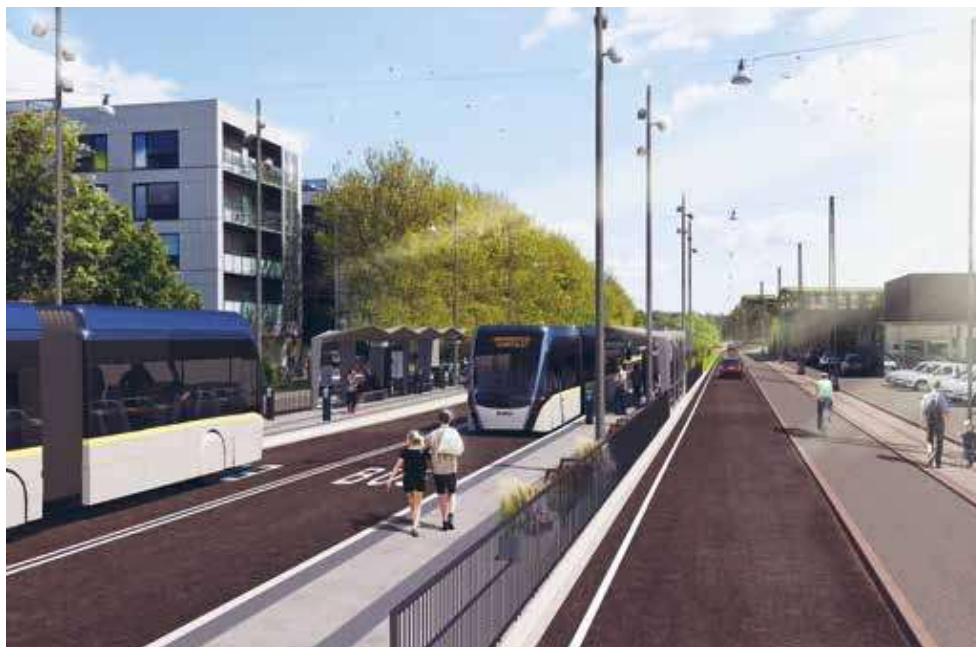
Figur 3: Stationen i Jyllandsgade er også standsningssted for bybusser. Derfor er perronerne ekstra lange (62,5 meter). Busvejen og perronerne er taget i brug af bybusserne, selvom strækningen endnu ikke står færdig i sin helhed.
