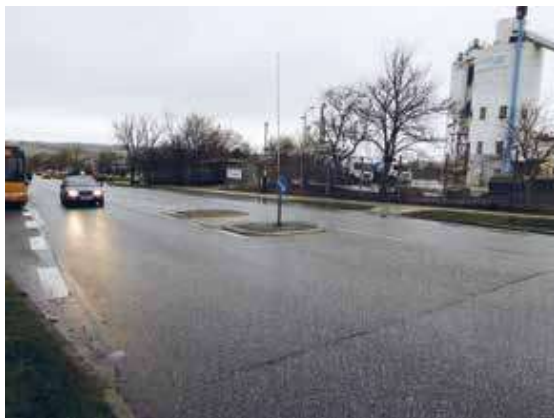
Graham Bells Vej, Aarhus Kommune. I forbindelse med et stoppested er vejen indrettet med en krydsningshelle. Hellen gør det lettere for fodgængere at krydse vejen, der er lang og bred. Foto: Via Trafik
