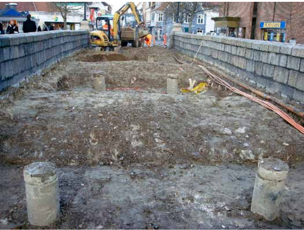
Figur 2. Renoveringen med synlige sprængbrønde. Foto: Vejle Kommune og Arne Mølgaard.
