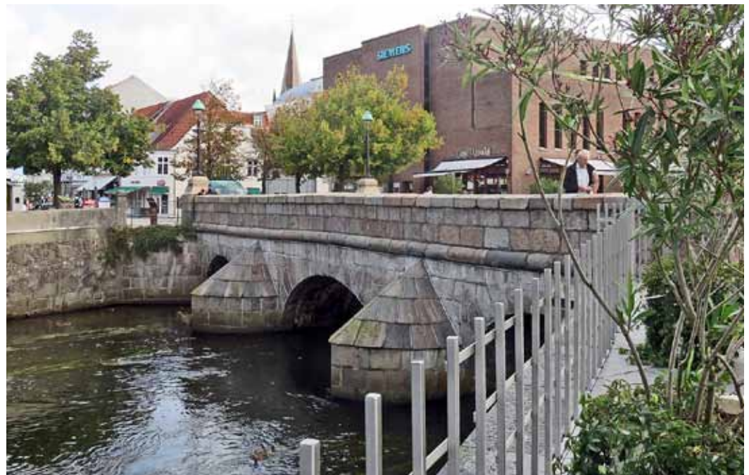
Figur 4. Den færdigrenoverede Sønderbro i september 2014. Foto: Vejle Kommune og Arne Mølgaard.
