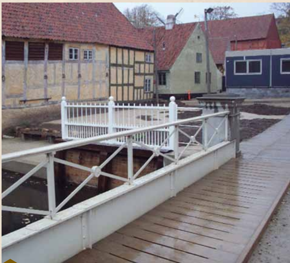
Figur 6. Den nybyggede stålbro i Den Gamle by, der danner overgangen mellem den gamle og nye bydel. Foto: AR.
