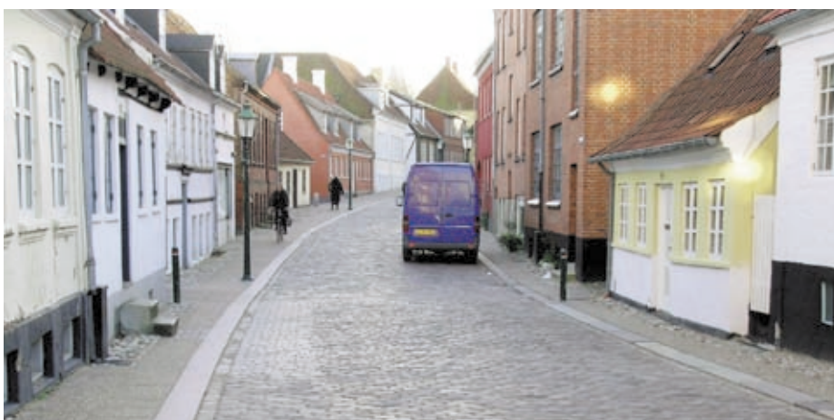
Kørebane og fortov efter ombygningen. Foto ingeniørstuderende Per Thoft Kærsgaard.
